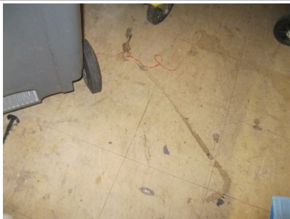
Déclaré - BP4 : RDC > LOCAL POUBELLES - Dalle de sol - EP- (Présence d'amiante)
