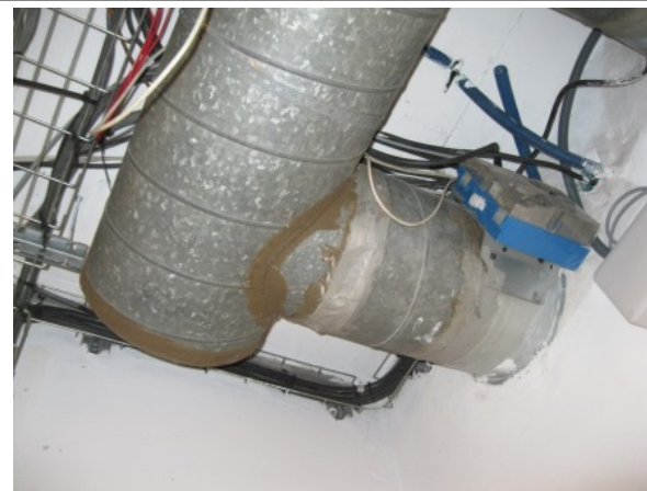
Déclaré - BP9 : RDC BAS > TOUTE SURFACE RESEAU VMC - Joint - BE- (Présence d'amiante)
