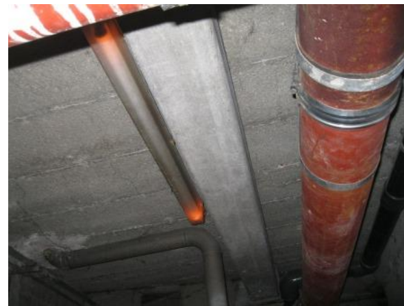
Déclaré - BP2 : SOUS SOL-2 > LOCAL AUTOCOM - Conduit - EP- (Présence d'amiante)
