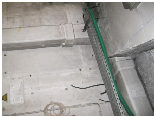
SD - BP2 : SOUS SOL-2 > LOCAL EPURATION - Conduit - EP- (Présence d'amiante)
