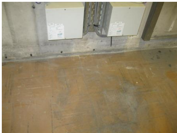
Déclaré - BP1 : SOUS SOL-2 > LOCAL AUTOCOM - Dalle de sol - EP- (Présence d'amiante)
