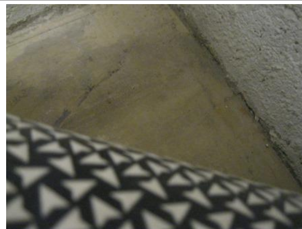
Déclaré - BP3 : RDC BAS > LOCAL REPROGRAPHIE - Dalle de sol - EP- (Présence d'amiante)
